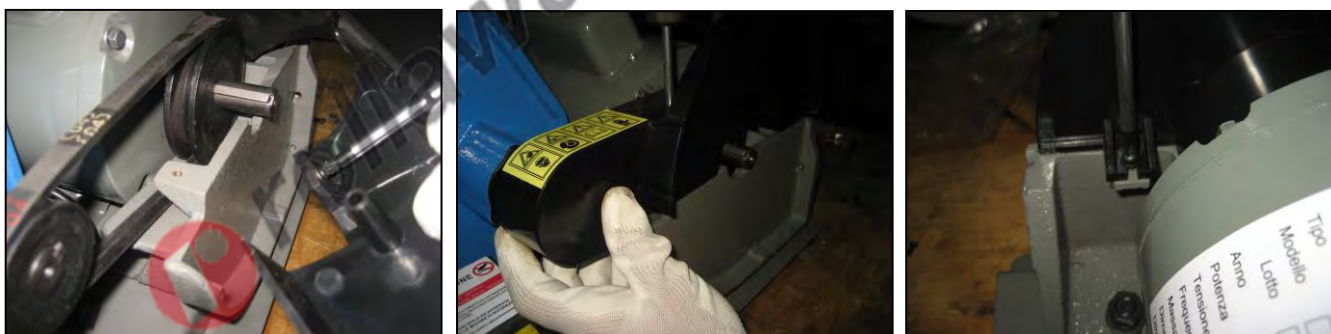
Figura 10 – Montaggio prima parte del carter della cinghia
