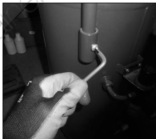
Figura 10 – Viti di bloccaggio maniglia.
