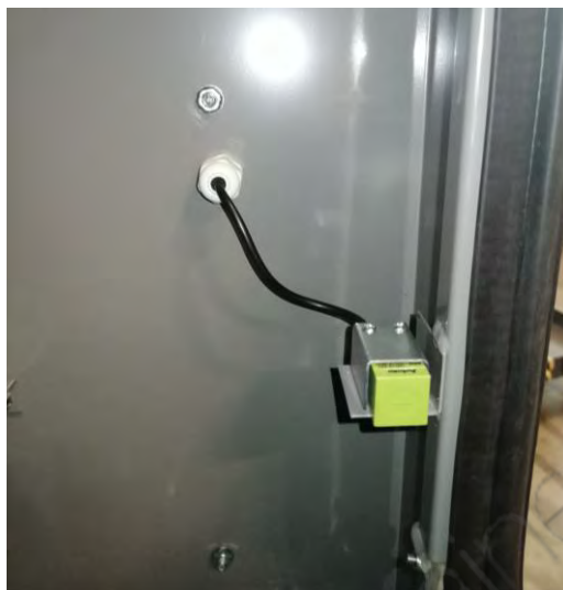
Figura 29 Interruttore micro magnetico di sicurezza
