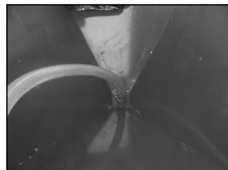
Figura 6 - Collegamento aspirazione sabbia.
