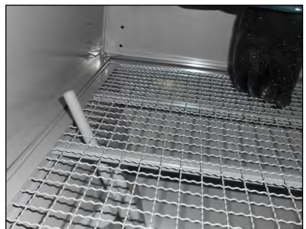
Figura 12 – Collocazione tubo metallico
