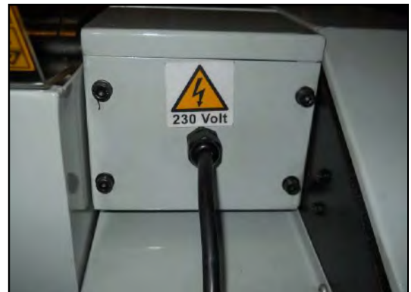
Figura 14 – Connessione alla rete di alimentazione
