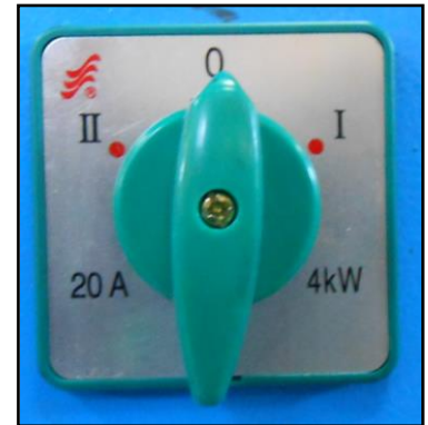
Figura 19 – Selettore velocità motore.
